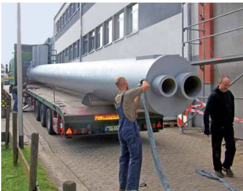
Rund 16 Meter lang ist der Schornstein für das BHKW im Helpuper Hallenbad.
