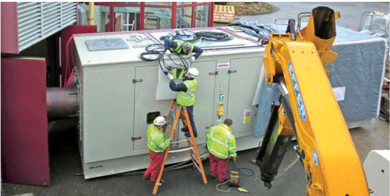
Anlieferung des Gasturbinen-Package im Heizkraftwerk „An der Bleiche“.
