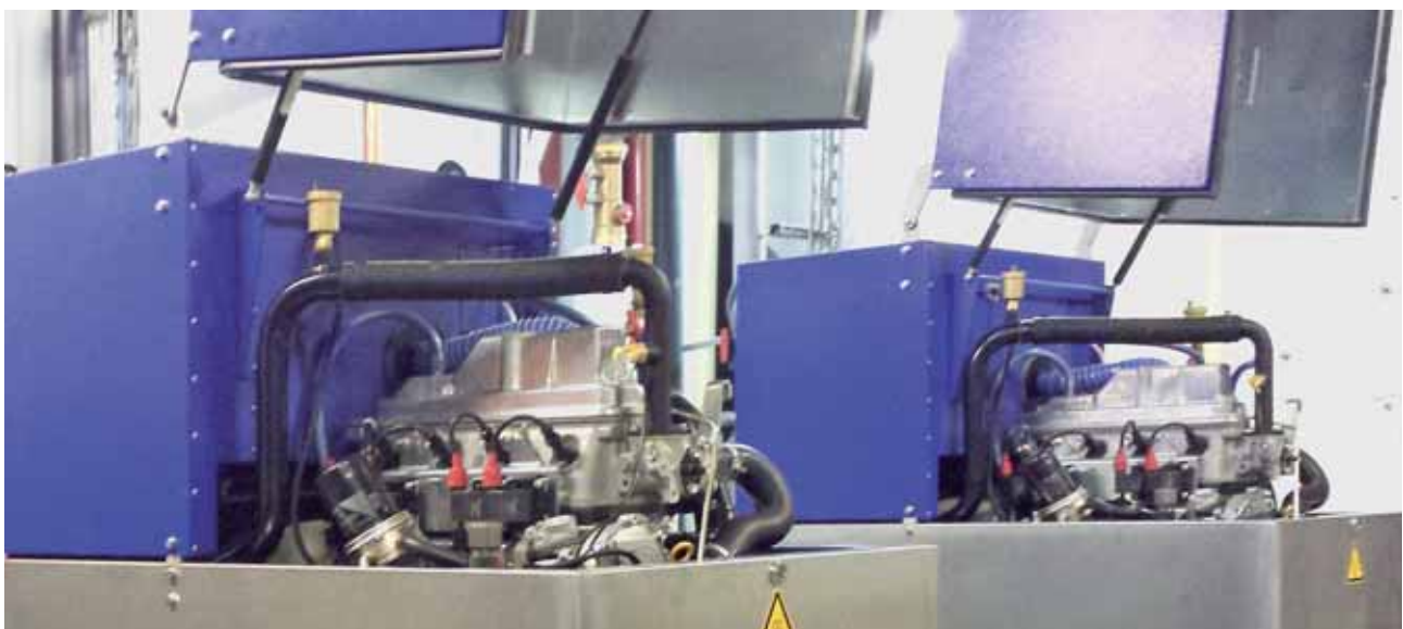
Wirtschaftlich und umweltschonend: Das Blockheizkraftwerk im Schulzentrum Werreanger.
