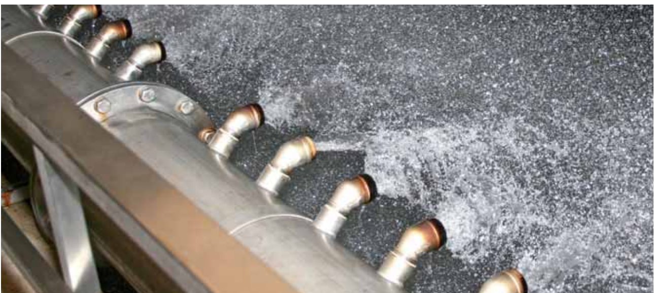
Sichert die Trinkwasserqualität in Lage: Einer der drei Reinwasserbehälter im Stadtgebiet.
