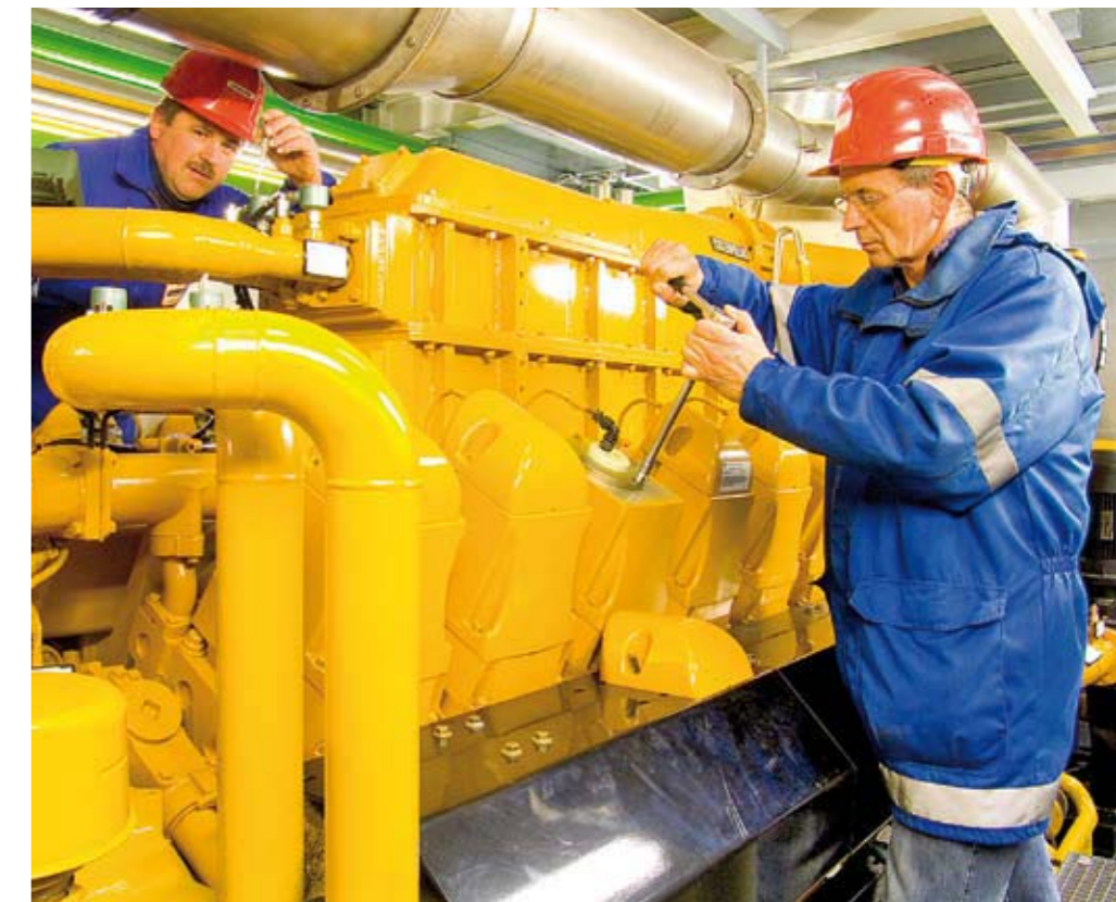
Eines der vielen, hocheffizienten Erdgas BHKW der Stadtwerke Lemgo.
