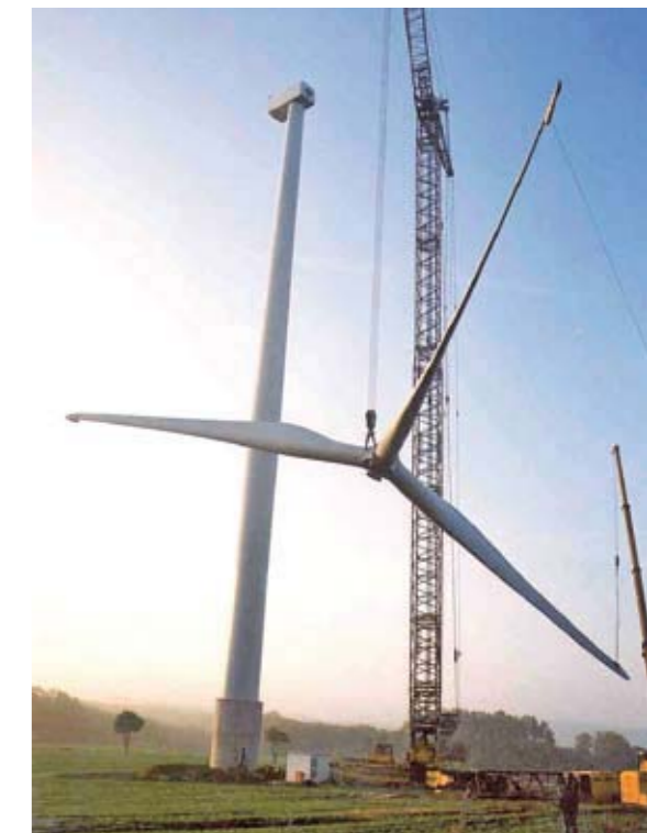
Montage der Windkraftanlage
