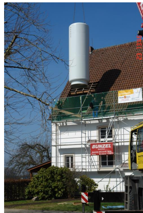
Einbau WW-Speicher Quelle: H. Adriaans
