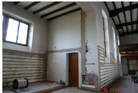
Einbau Wandheizung Quelle: H. Adriaans
